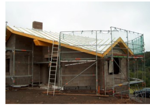
Aufdachisolierung + Gaube
