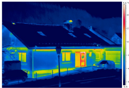
Aufsparrenisolation + überzeugende Thermografie, die VH-Fassadensanierung folgt 2011.
