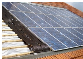
Unter Photovoltaik + Solar
