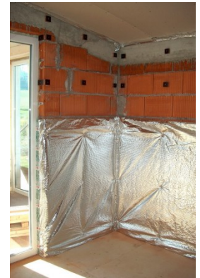
Innenisolierung der Wände
