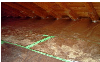
EnEV-Nachrüstungsverpflichtung Isolierung der obersten Geschosdecke < 0,24 W / (m²·K)
