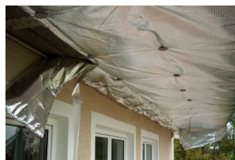
Balkonisolierung von unten
