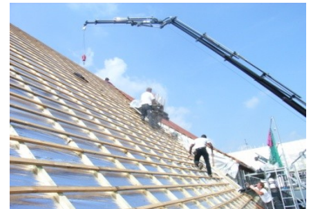
Dachsanierung Brinkmannschule Langenberg. Einsparung ca. 33 %
