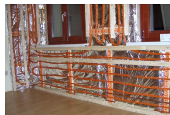
Innenisolierung mit Wandheizung
