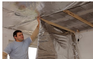
Innenisolierung der OG-Decke
